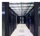
Стр. 111 Система разделения горячих и холодных коридоров
